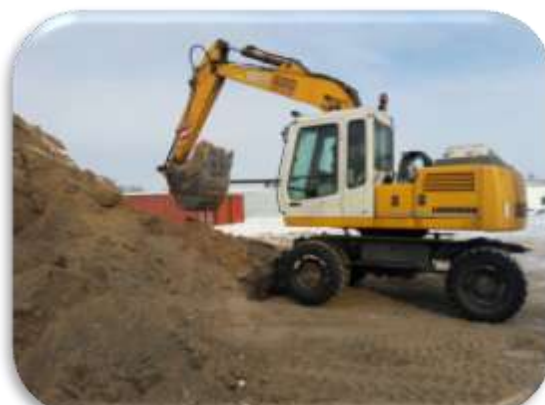
Экскаватор ЭО-LEBHERR (Германия)
